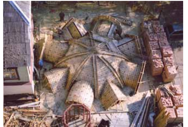
Опалубка восьмерика на земле.
