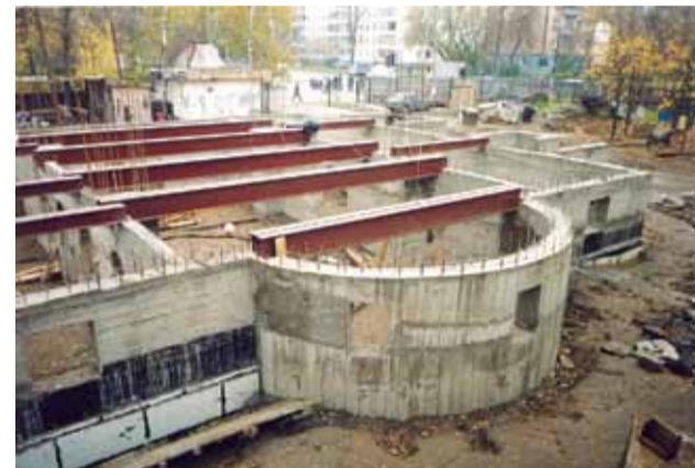
Сентябрь 2003 г. Сооружение перекрытия.
