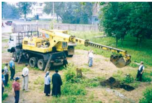
14 июля 2003 г. Первый ковш земли для котлована.
