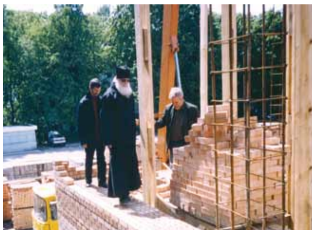
Июнь 2004 г. О. Борис с генпрорабчиком С. Соколянским и прорабом Пименом.
