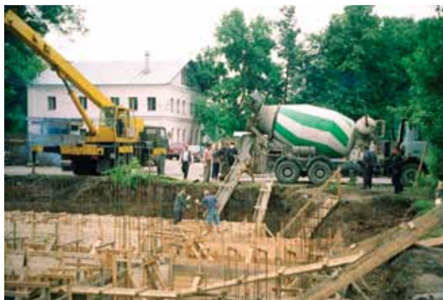
Август 2003 г. Заливка бетона под фундамент.
