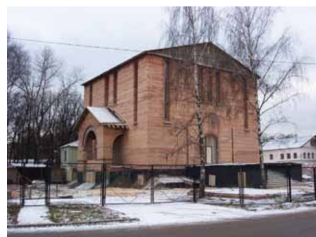
Ноябрь 2004 г. Окончание возведения стен.
