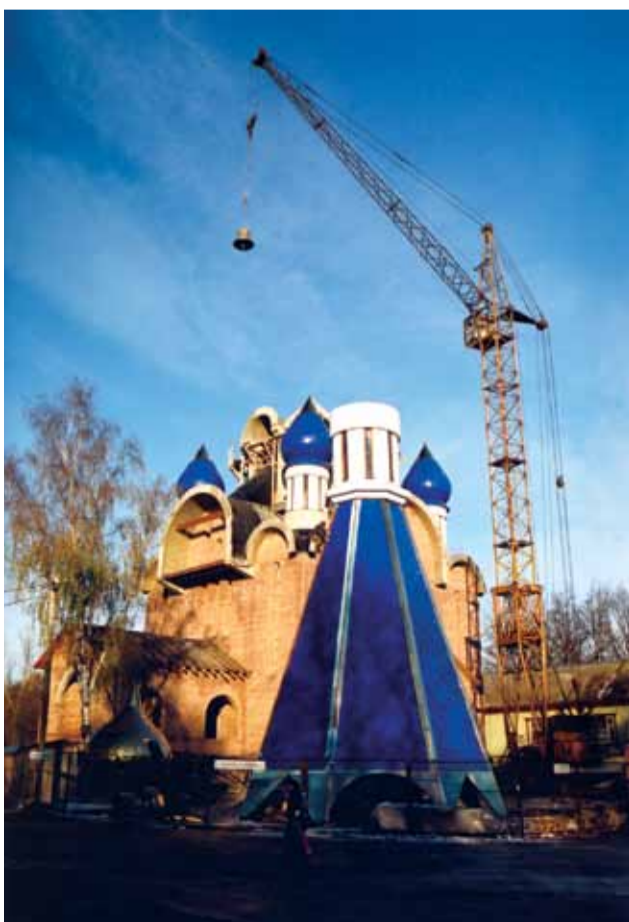
Монтаж шатра и центральной главки.
