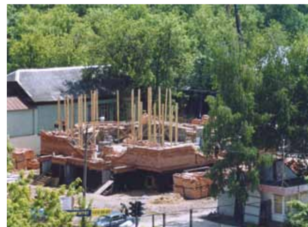
Июнь 2004 г. Начало кирпичной кладки.
