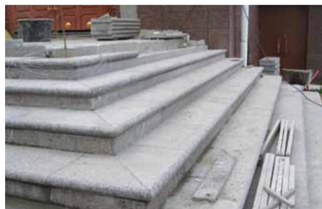
Укладка гранитных ступеней
