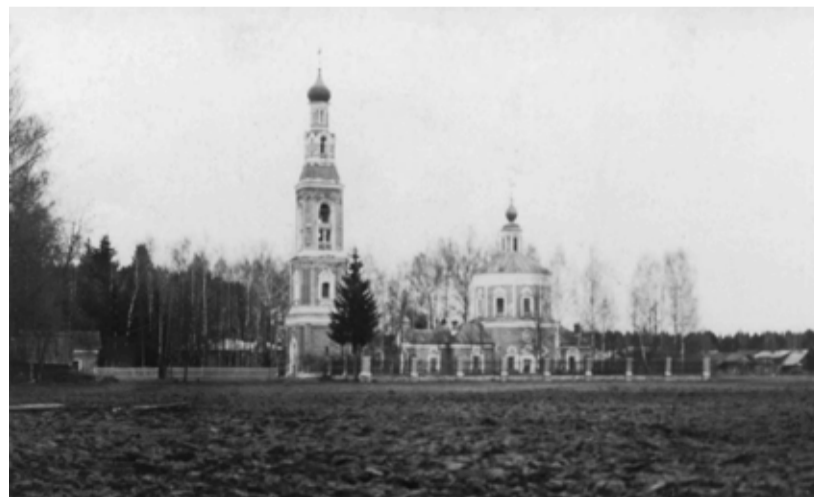
Разрушенная Богородицерождественская церковь. Вид с юга
