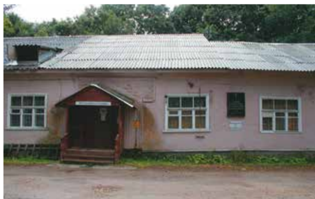
Временное помещение храма в доме Крафта. Фото Александра Опалева
