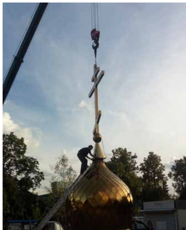
Установка на земле Креста в главку
