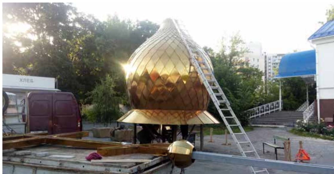
Последние приготовления к монтажу, 26 июля
